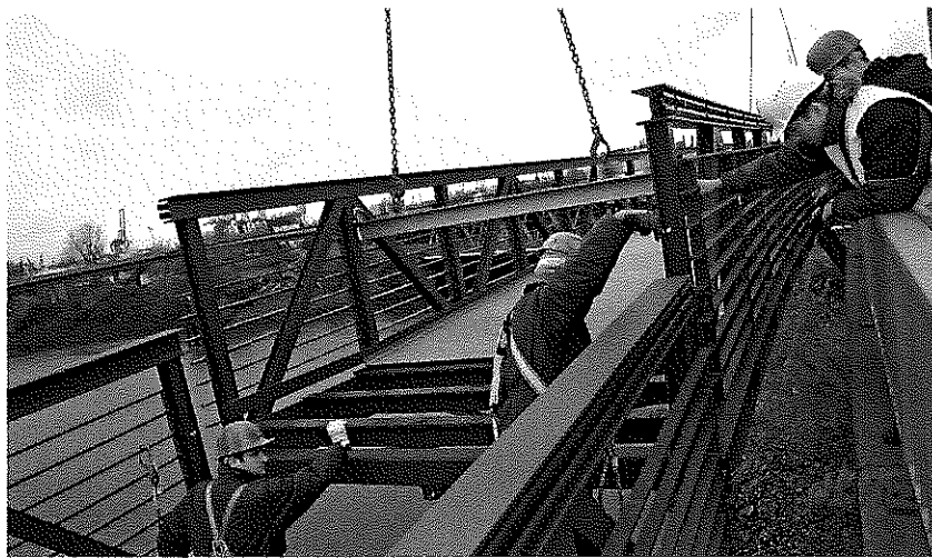
Einbau eines über zehn Tonnen schweren Segments für die Brücke an der Klütjenfelder Hochstraße
